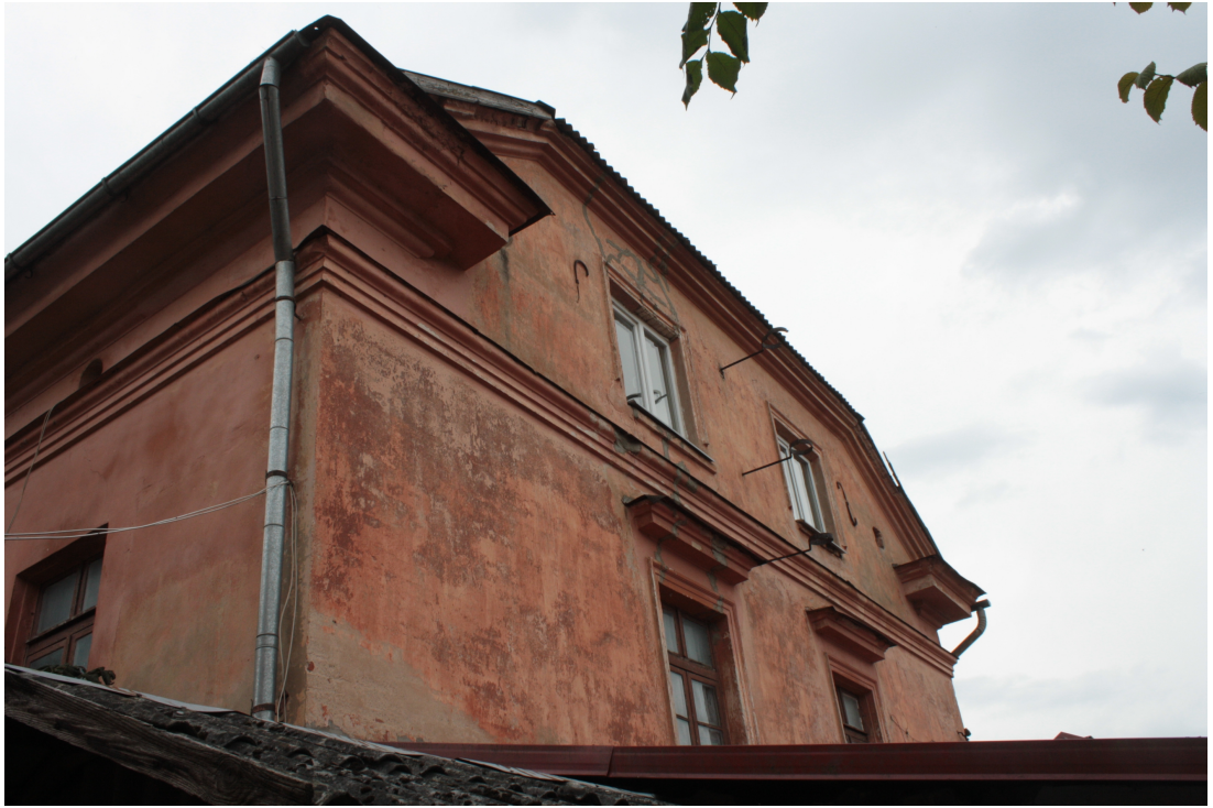
Liela_32_88010120191001_fasade8 Skats uz rietumu fasādes augšdaļu.
