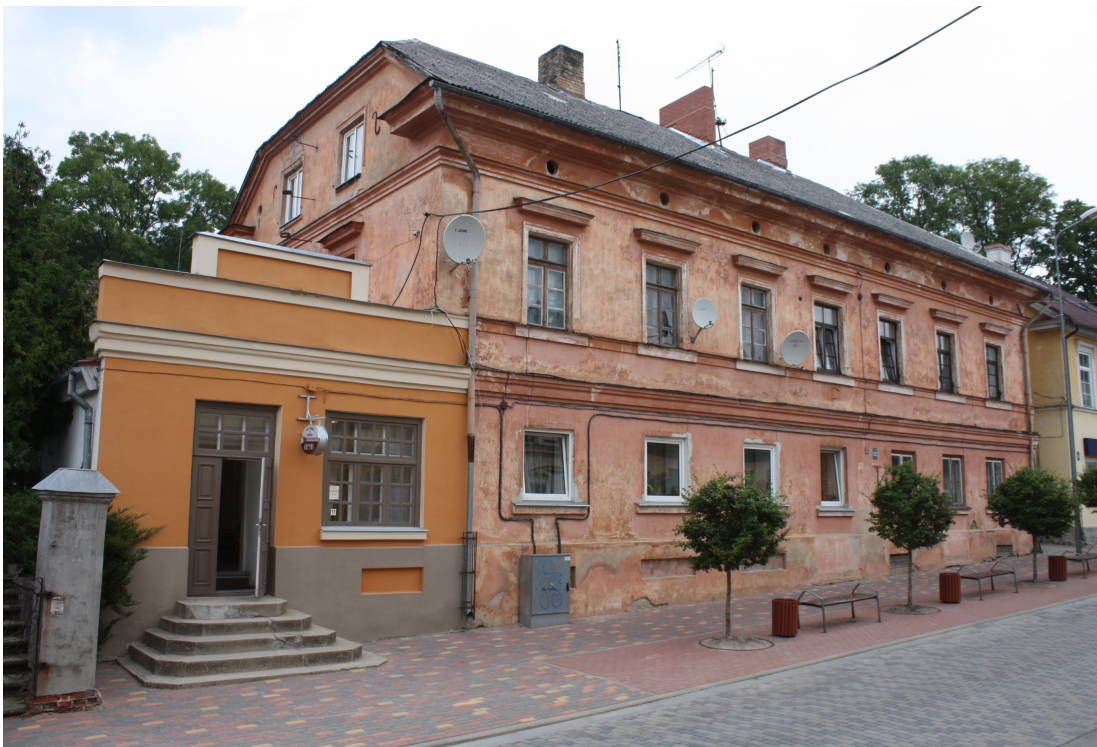
Liela_32_88010120191001_fasade2 Skats uz ēku no dienvidiem. Ēkas R galā 1881.gada piebūve.
