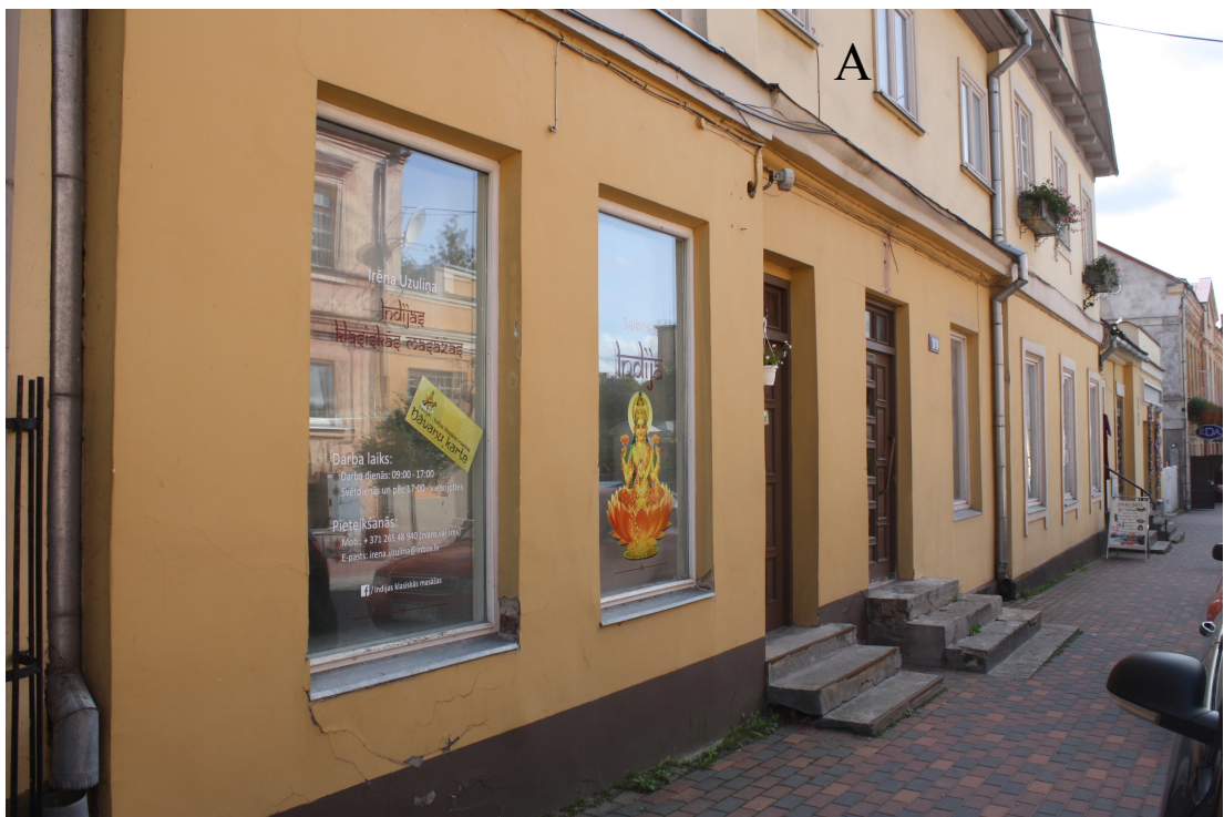
Lielaa_33_88010130006001_fasade2 Skats uz ēkas ielas fasādes daļu no ziemeļaustrumiem. A – 2.stāvs uzcelts 20.gs.2.pusē.
