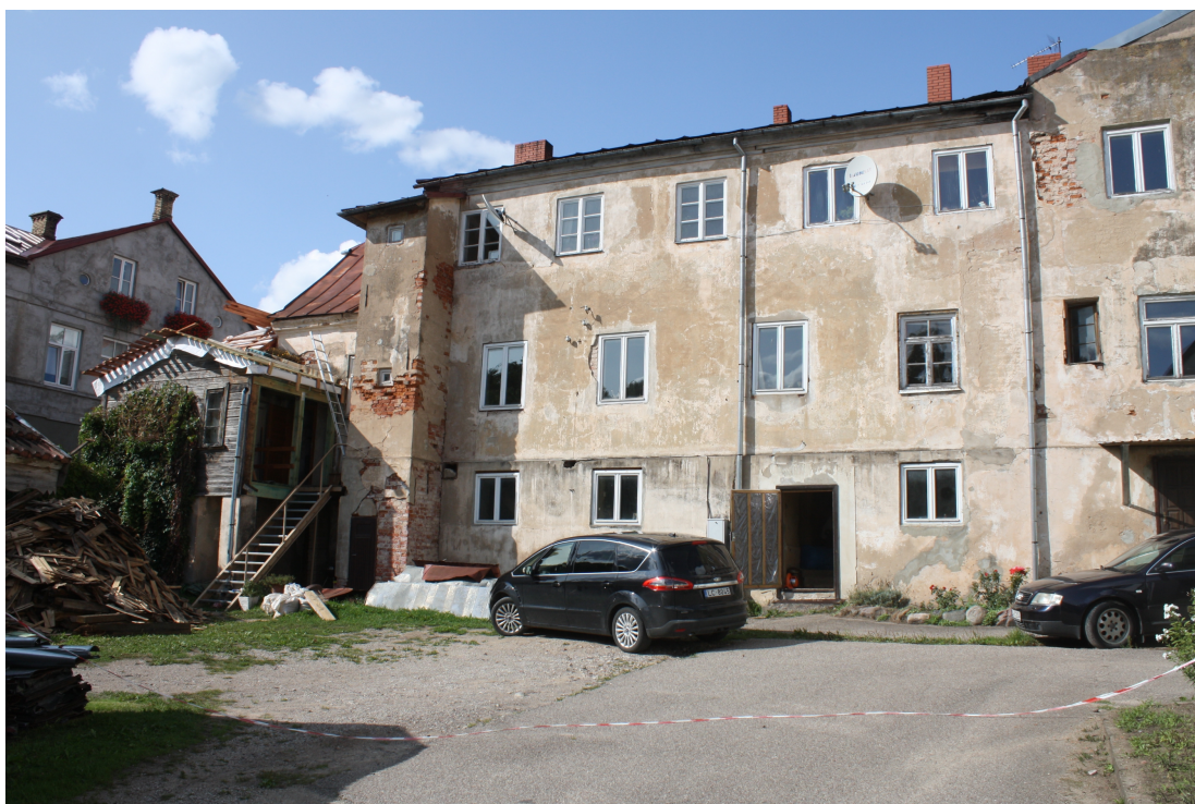
Lielaa_33_88010130006001_fasade3 Skats uz ēku no dienvidiem. Kreisajā pusē 19.gs.2.puses piebūves.
