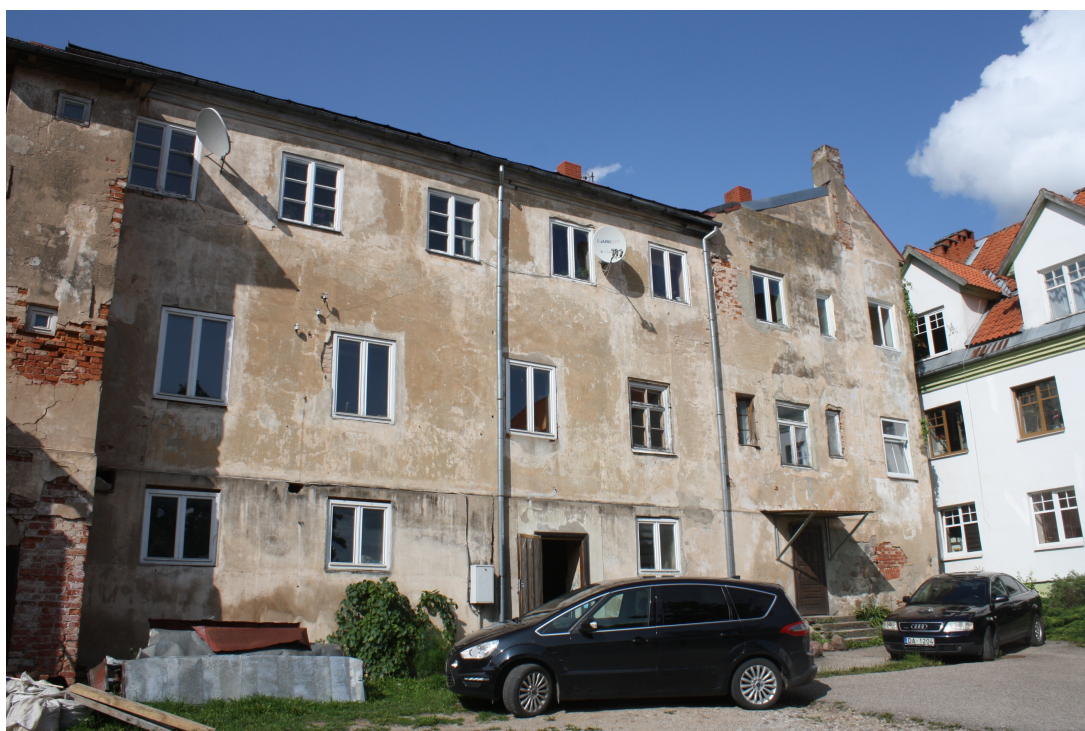
Lielaa_33_88010130006001_fasade4 Skats uz ēku no dienvidrietumiem.
