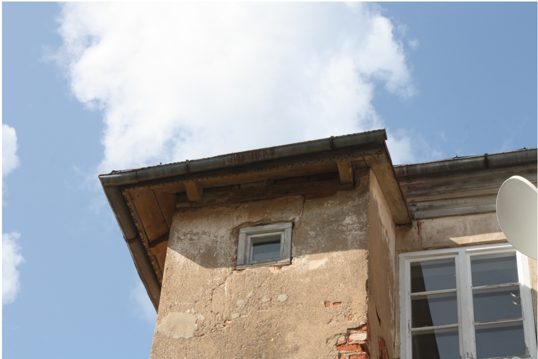
Liela_33_88010130006001_fragments3 Skats uz 20.gs. sāk. paaugstinātu ateju izbūvi. Saglabājies oriģinālais robdēlis.
