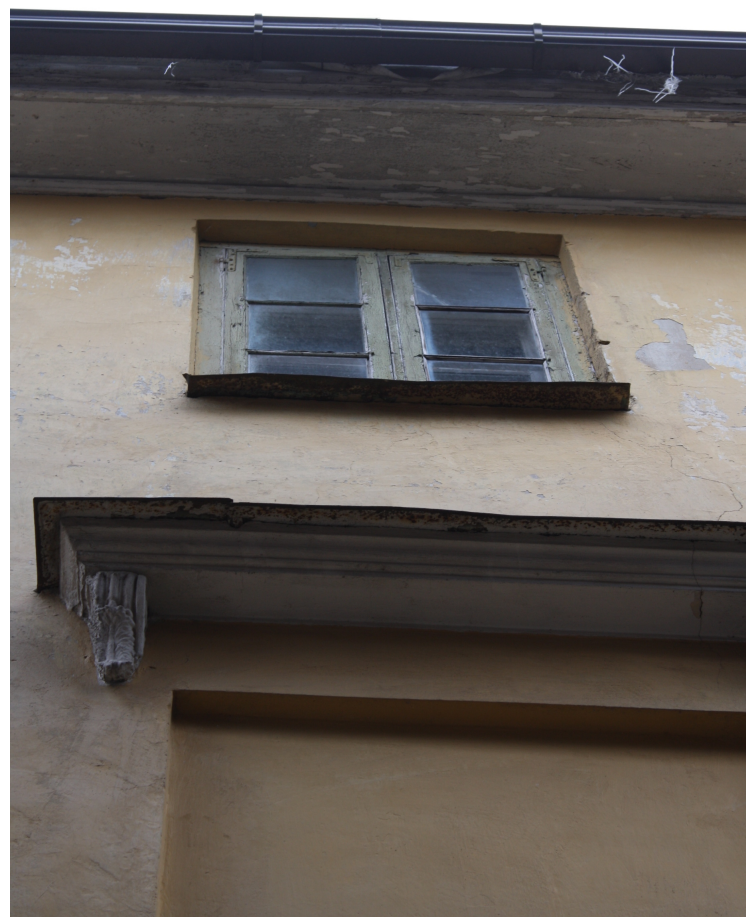
Liela_34_88010120002001_logs1 Skats uz sākotnējo logu ēkas zelminī. Saglabājies aprīkojums.
