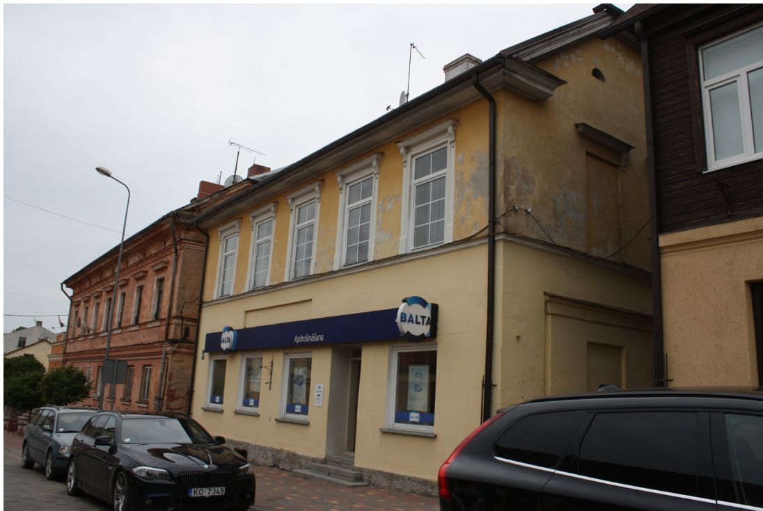
Lielaa_34_88010120189001_fasade1 Skats uz ēku no dienvidaustrumiem. 1.stāvā 20.gs.4.cet. mainīts ailojums.
