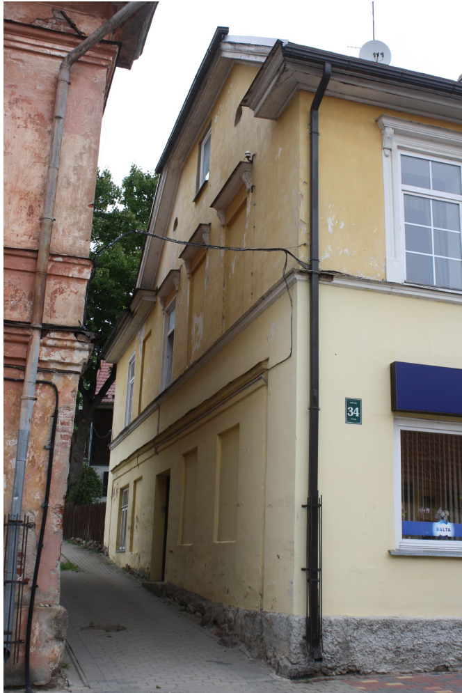
Lielaa_34_88010120002001_fasade5 Skats uz ēkas rietumu fasādi.
