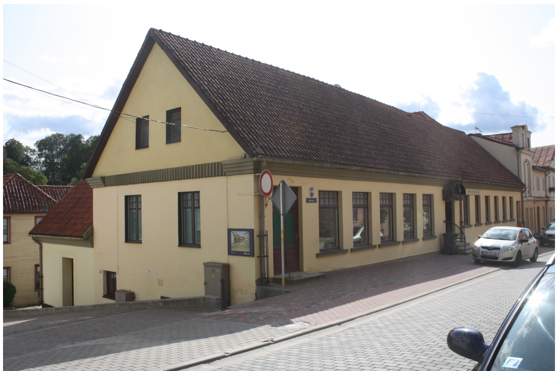
Lielaa_35_88010130142001_fasade2 Skats uz ēku no ziemeļaustrumiem.
