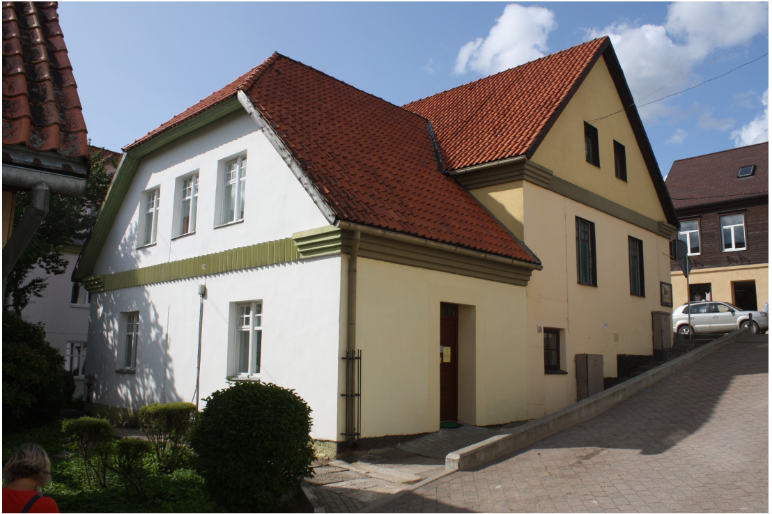
Lielaa_35_88010130142001_fasade3 Skats uz ēku no dienvidaustrumiem. Piebūves sākotnējais apjoms būtiski izmainīts 1980.gados.
