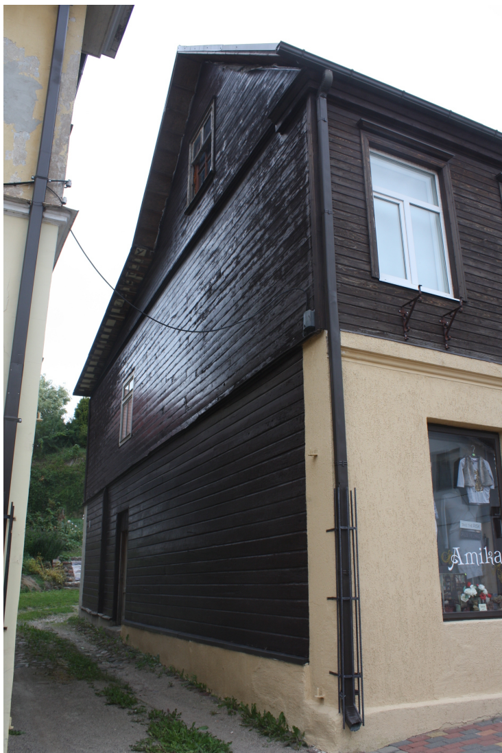
Lielaa_36_88010120049001_fasade4 Skats uz ēkas rietumu fasādi no dienvidrietumiem.
