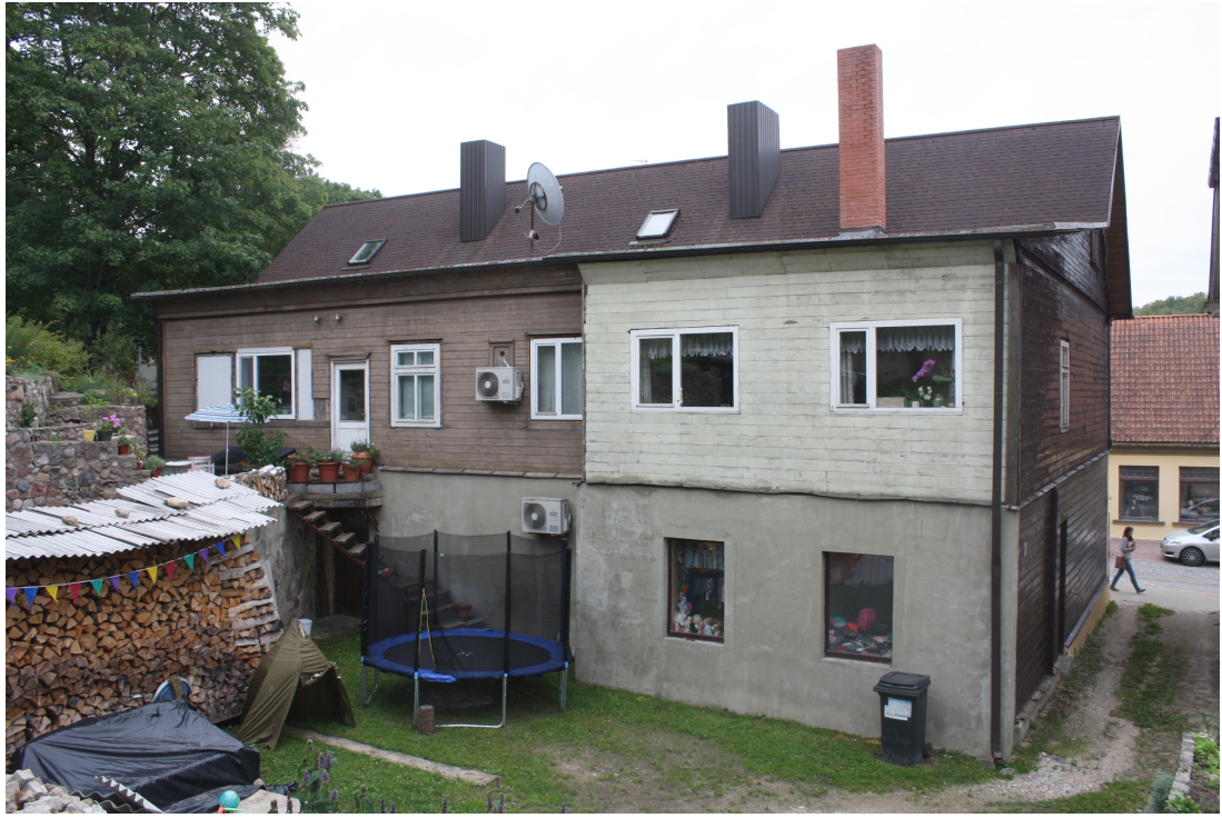
Lielaa_36_88010120049001_fasade6 Skats uz ēku no ziemeļrietumiem. Ēkai dažādu periodu piebūves.
