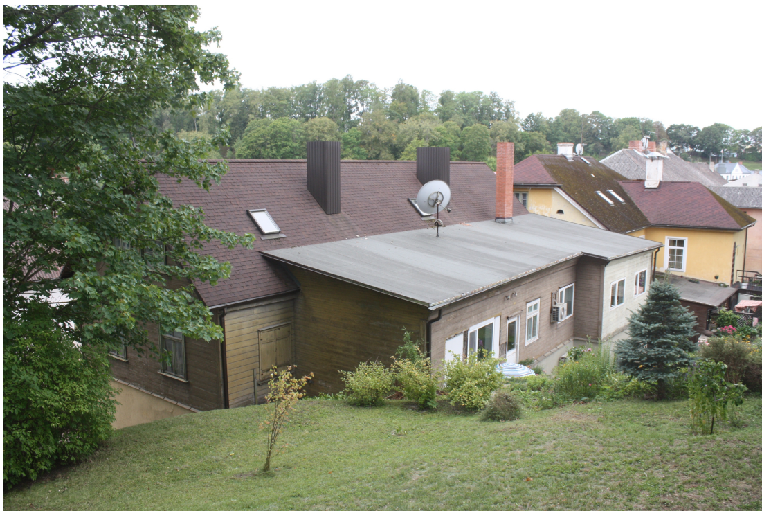
Lielaa_36_88010120049001_fasade3 Skats uz ēku no ziemeļaustrumiem. Piebūves vēsturiskas, pārbūvētas 20.gs.2.pusē.
