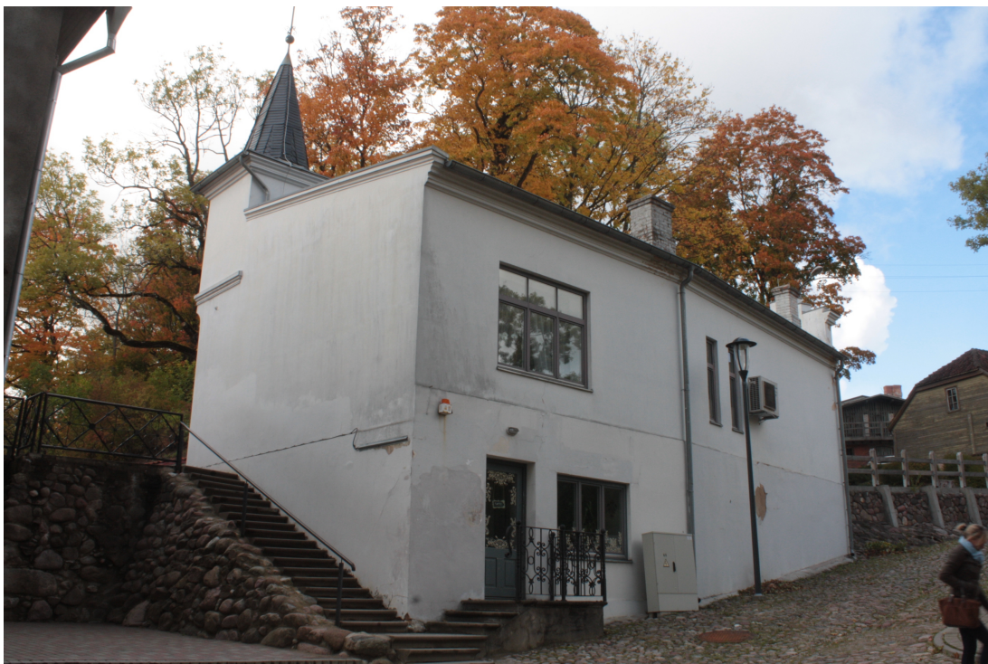
Lielaa_41_88010130053001_fasade3 Skats uz ēku dienvidiem (fasāde pret Ūdens ielu).
