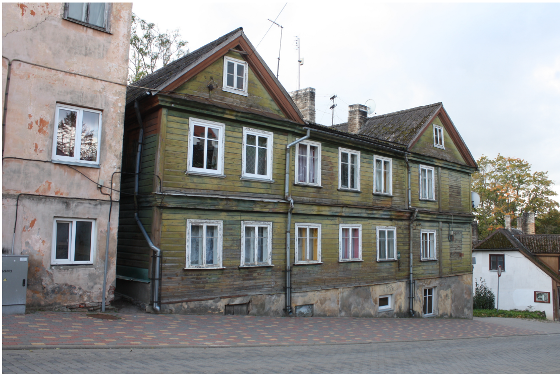
Lielaa_43_88010130083001_fasade2 Skats uz ēku no ziemeļrietumiem. Iespējams, 2.stāva vidusdaļa izbūvēta vēlāk kā malas ar frontonu (hipotēze, varētu pārbaudīt tikai ēkas izpētē).
