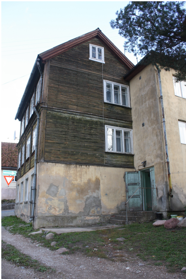
Lielaa_43_88010130083001_fasade5 Skats uz ēkas dienvidu galu no dienvidaustrumiem.
