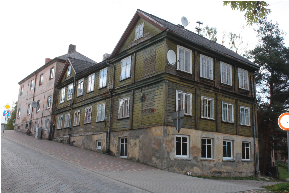
Lielaa_43_88010130083001_fasade1 Skats uz ēku no dienvidrietumiem. Zudis vēsturisks lievenis ar kāpnēm un balkonu, pārbūvētas sākotnējās durvju ailas.
