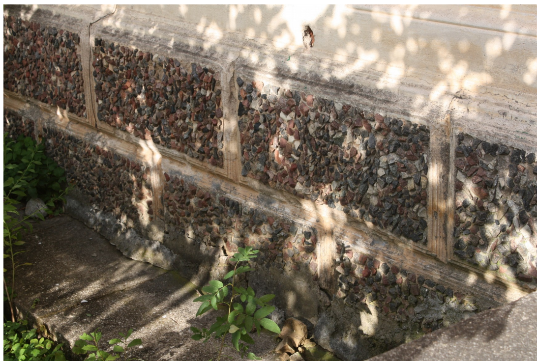
Rozju_1_88010130077001_fragments2 Sākotnējā (1905.g.) cokola apdare galvenajā fasādē.
