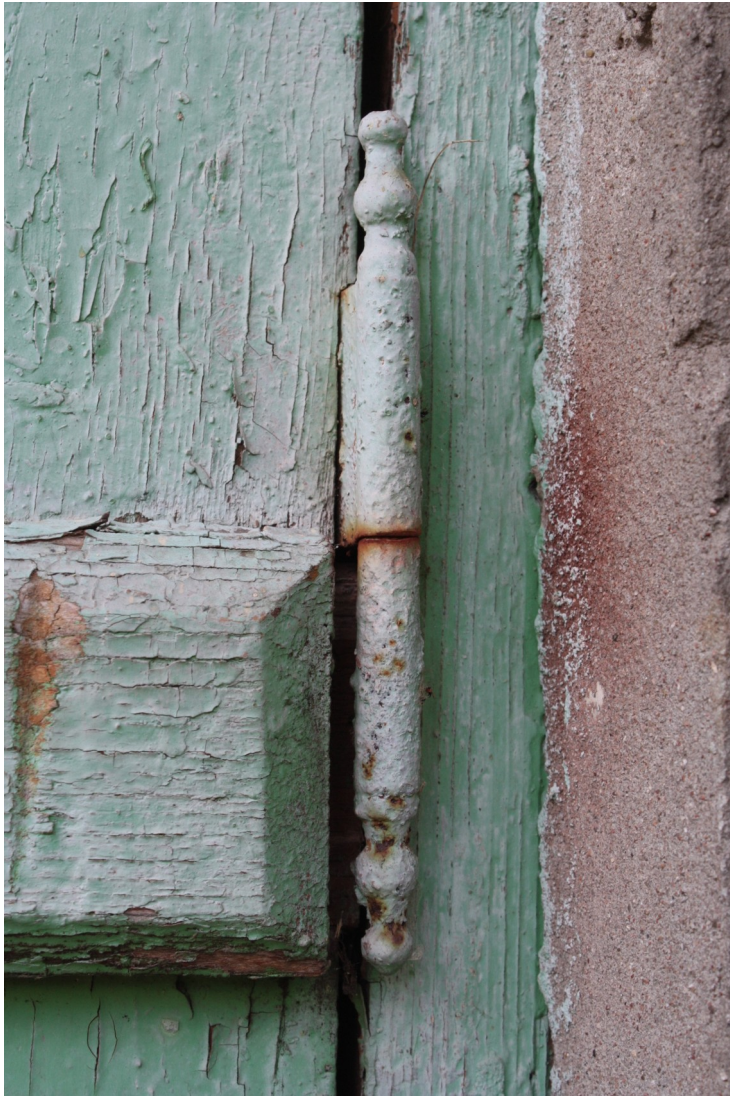
Rozju_1_88010130077001_durvis3 Sākotnējā (1905.g.) durvju vira.
