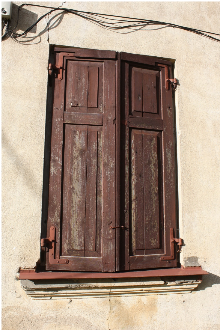
Rozju_1_88010130077001_slegis1 Sākotnēji (1905.g.) slēgi ar oriģinālo aprikojumu.
