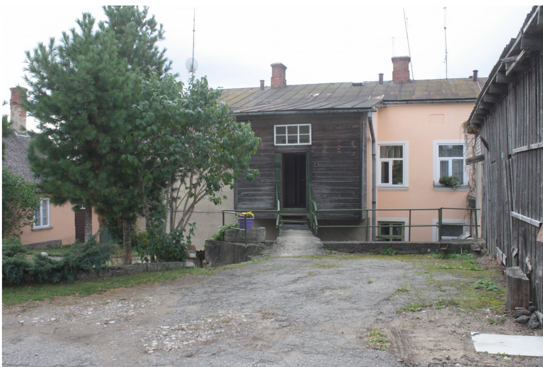
Rozju_1_88010130077001_fasade4 Skats uz ēku no austrumiem.
