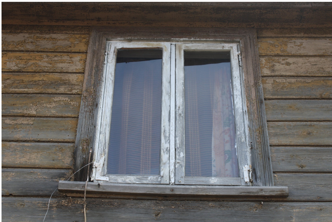
Rozju_9_88010130095001_logs2 Pārveidots vēsturiskais logs ar atkārtoti izmantotām kāšu virām.
