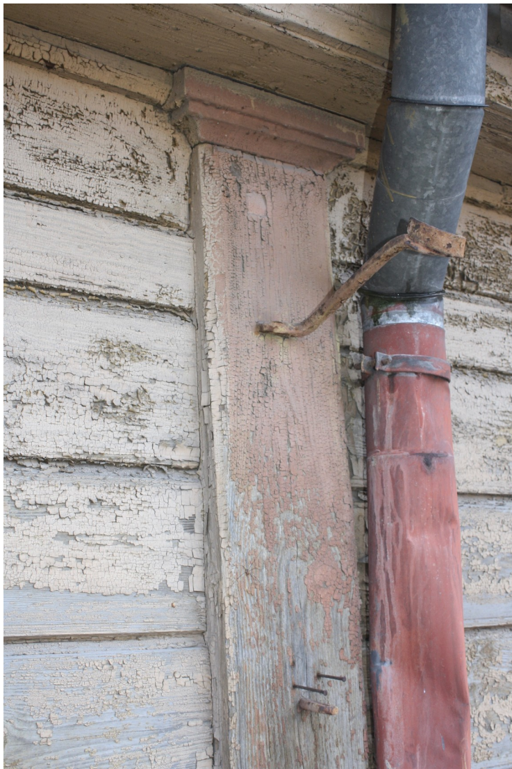
Rozju_9_88010130095001_fragments2 Sākotnējs (19.gs.1.puse) pilastrs un vēsturisks karogkāta turētājs.
