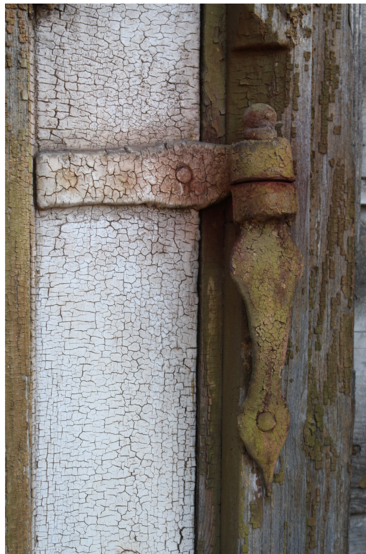
Rozju_9_88010130095001_durvis2 Sākotnējo durvju oriģinālā kāšu vira.
