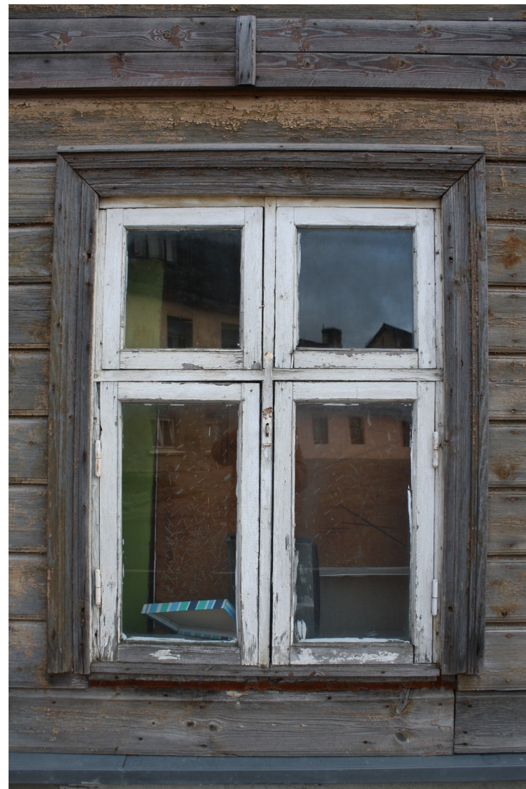
Rozju_9_88010130095001_logs1 Vēsturisks (19.gs.4.cet.) logs ar oriģinālo aprīkojumu.
