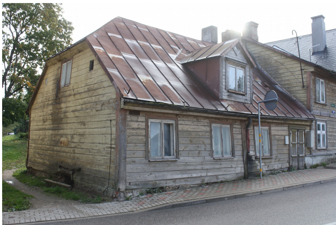
Rozju_9_88010130095001_fasade2 Skats uz ēkas vienkāršā daļu no ziemeļrietumiem.
