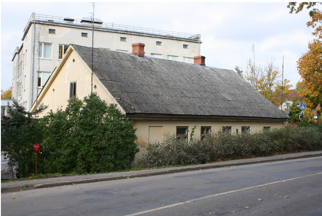
Saules_1_88010130126001_fasade2 Skats uz ēku no dienvidaustrumiem.
