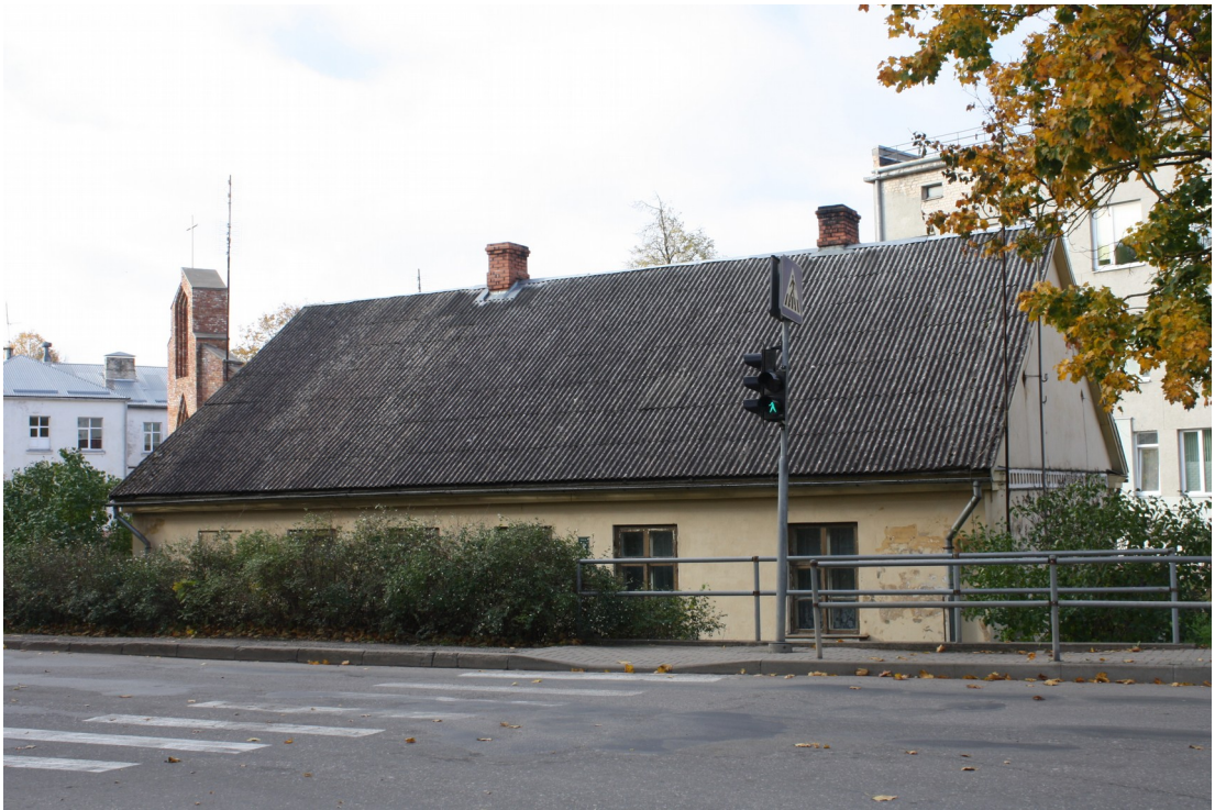
Saules_1_88010130126001_fasade1 Skats uz ēku no ziemeļaustrumiem.
