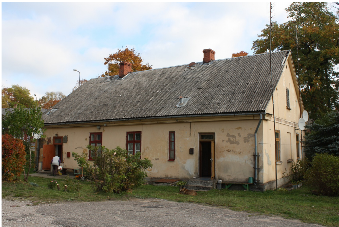
Saules_1_88010130126001_fasade5 Skats uz ēku no dienvidrietumiem.
