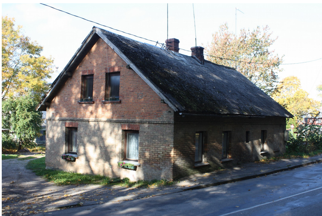
Saules_3_88010130127001_fasade2 Skats uz ēku no dienvidaustrumiem.
