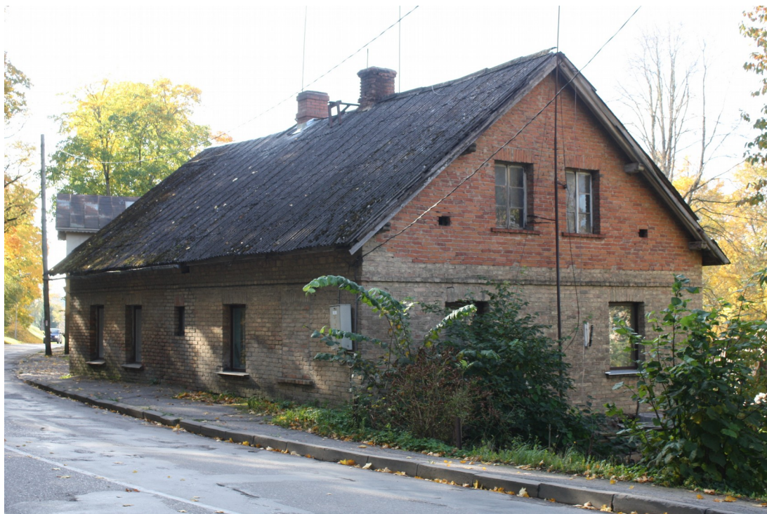
Saules_3_88010130127001_fasade1 Skats uz ēku no ziemeļaustrumiem.
