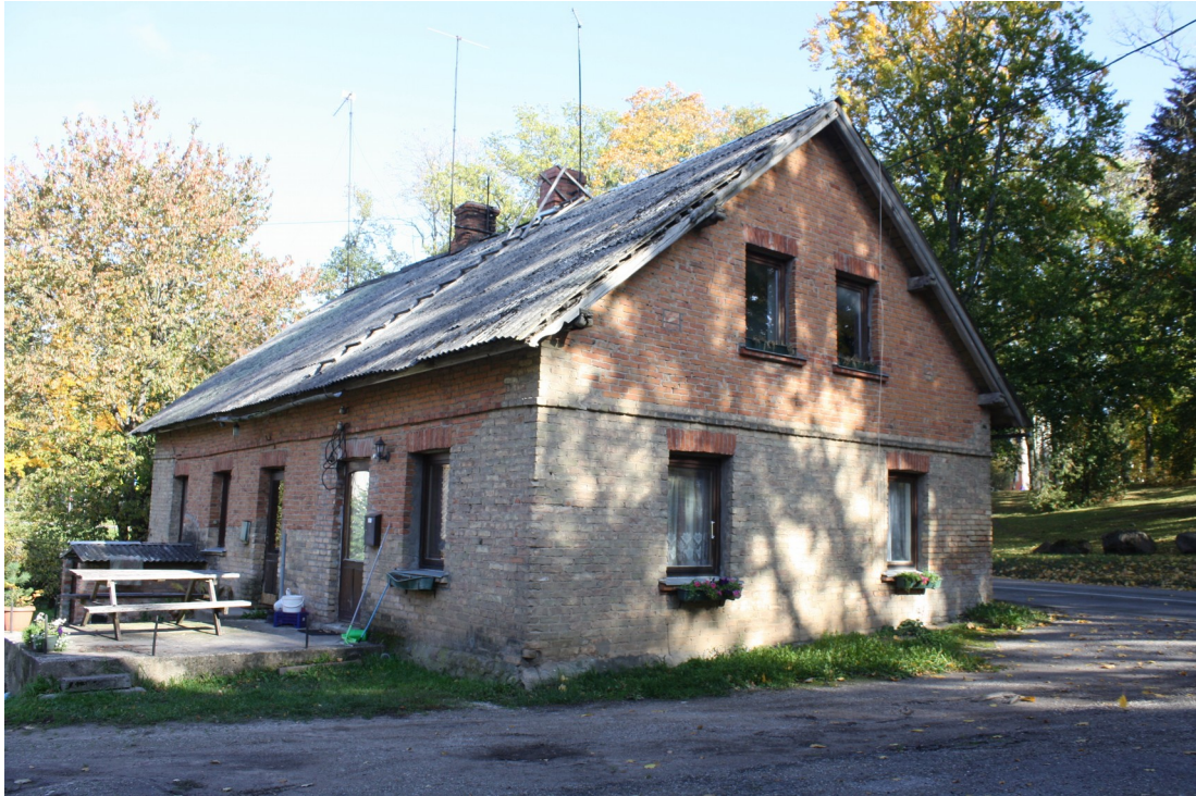
Saules_3_88010130127001_fasade3 Skats uz ēku no dienvidrietumiem.
