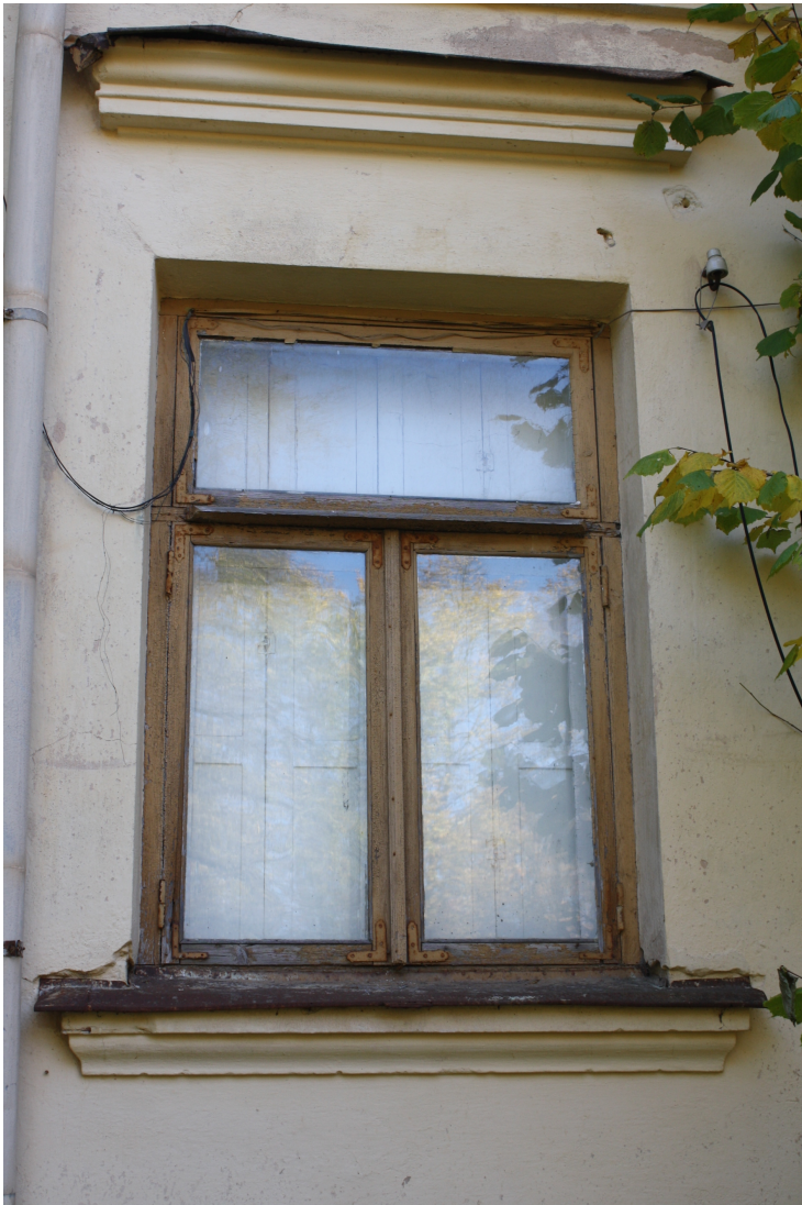
Saules_5_88010130128001_logs3 Sākotnējs (19.gs./20.gs. mija) logs ar oriģinālo aprīkojumu, mūra palodzi un sandriku.
