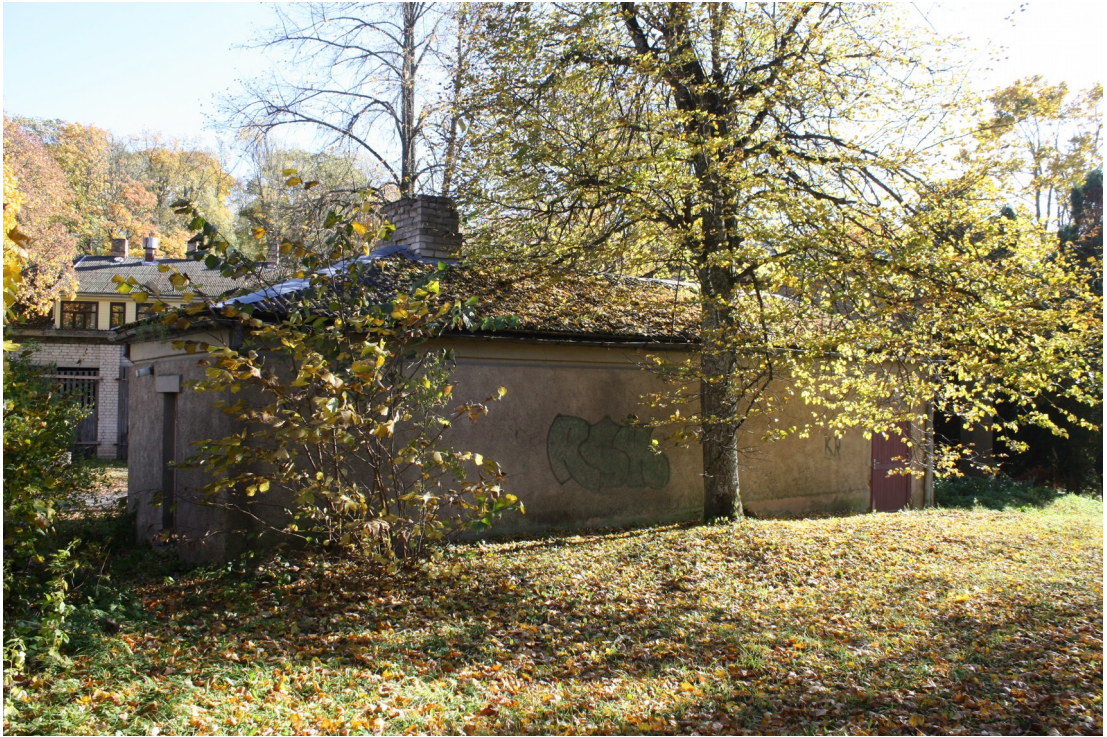
Saules_7B_88010130079001_fasade3 Skats uz ēku no ziemeļrietumiem.
