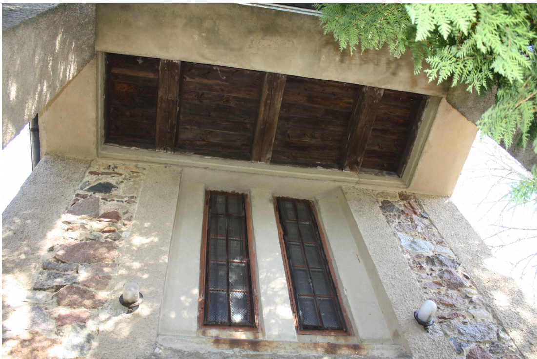
Saules_7B_88010130079001_fragments1 Skats uz ēkas centrālās daļas 2.stāva līmeni virs bijušās galvenās ieejas. Redzama sākotnējā (1959.g.) fasāžu apdare un logi.
