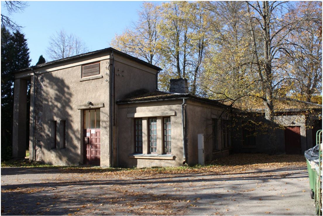
Saules_7B_88010130079001_fasade1 Skats uz ēku no ziemeļaustrumiem.
