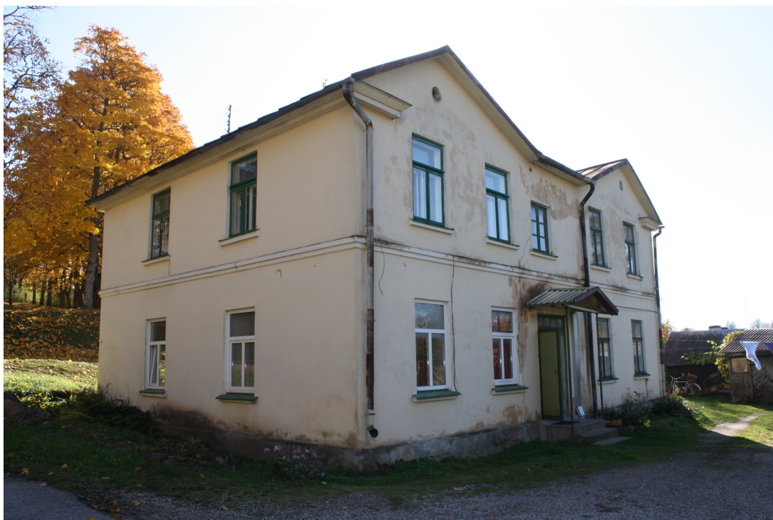
Saules_9_88010130129001_fasade3 Skats uz ēku no ziemeļiem.
