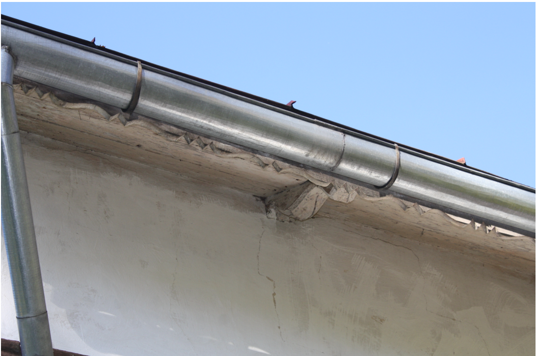
Saules_13_88010130025001_detala1 Sākotnējs (20.gs.1.cet.) dekoratīvi griezts dēlis gar jumta apakšējo malu un dekoratīvi griezti spāru gali.
