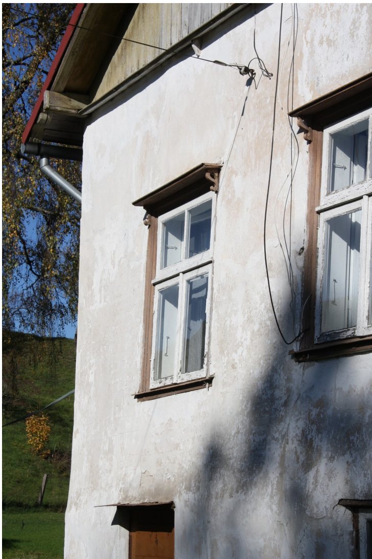
Saules_13_88010130025001_fragments1 Sākotnējs (20.gs.1.cet.) logs ar oriģinālo ailas apdari.
