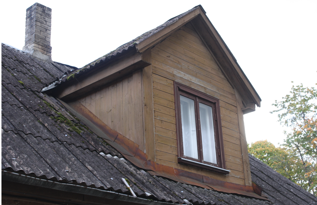
Uudens_1_88010130082001_fragments1 19.gs.4.cet. jumta izbūve galvenajā fasādē.
