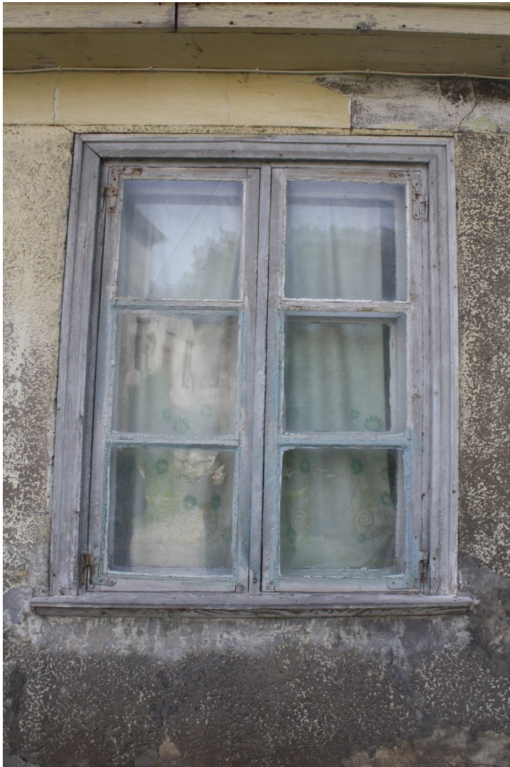
Uudens_3_88010130049001 _logs1 Sākotnējs logs (19.gs.2.cet.) ar oriģinālajām apmalēm un aprikojumu
