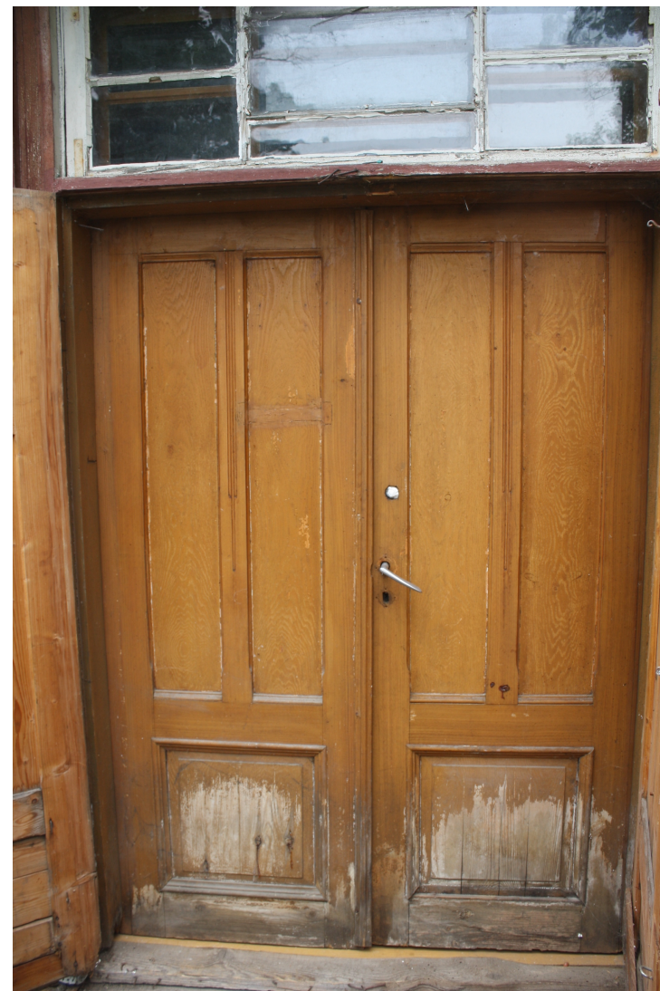
Uudens_5_88010130144001_durvis1 Vēsturisko ārdurvju iekšējās vērtnes (ap 1910.gadu).
