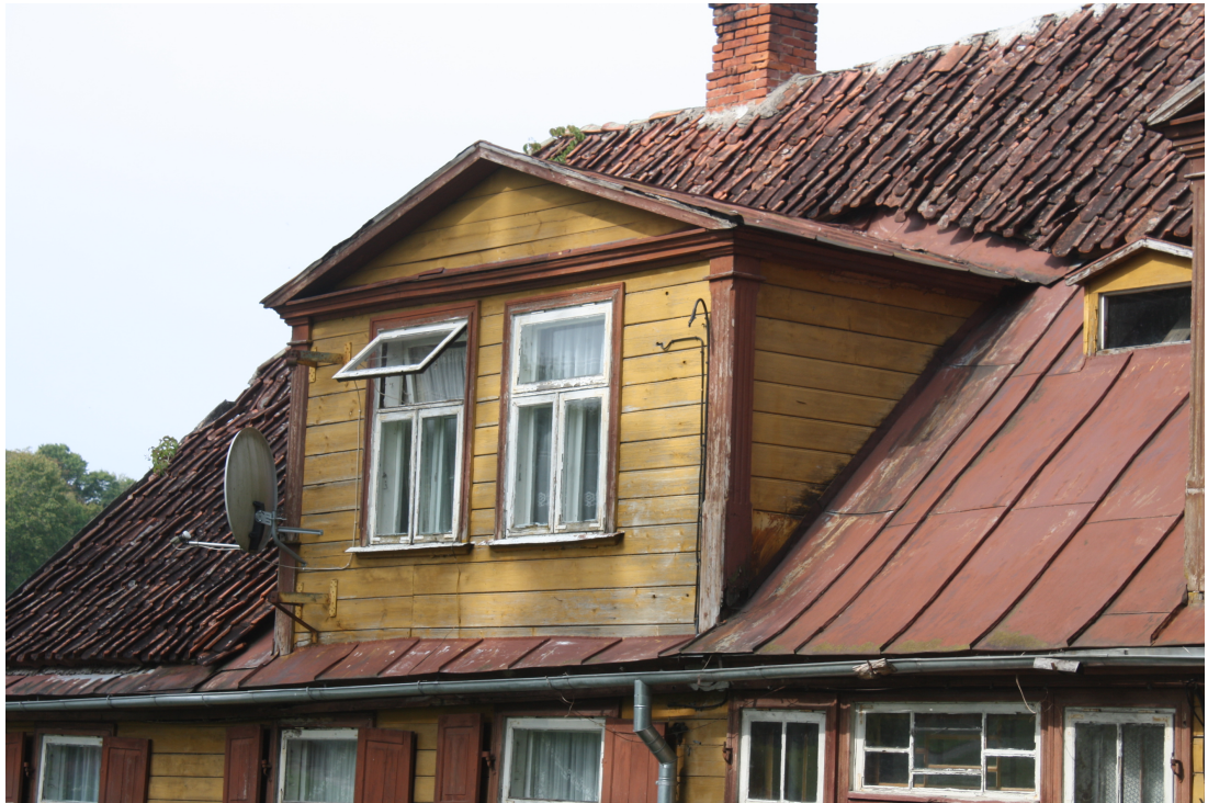
Uudens_5_88010130144001_fragments2 Vēsturiska jumta izbūve (ap 1910.gadu).
