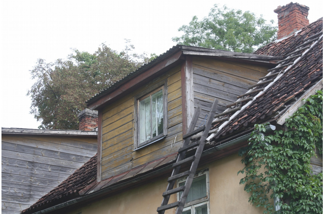
Uudens_5_88010130144001_fragments3 Vēsturiska jumta izbūve (ap 1910.gadu).
