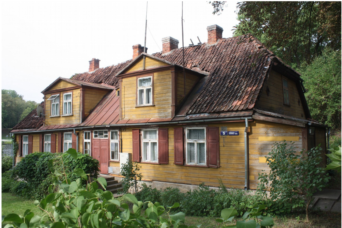
Uudens_5_88010130144001_fasade1 Ēkas kopskats skatā no austrumiem.
