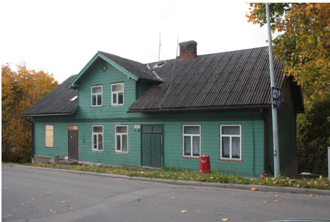
Voldemaara_Rugjeena_5_88010130004001_fasade1 Skats uz ēku no ziemeļaustrumiem.
