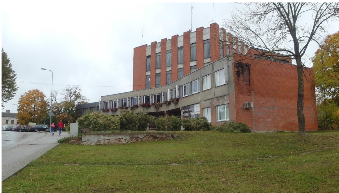
Pasta un telefonu centrāles ēka celta 1966. gadā Lielajā ielā 4. Viens no diskutablākajiem objektiem Talsu vēsturiskajā centrā. Nenoliedzami tā masīvais apjoms degradē harmonisko vecpilsētas ainavu, bet ēkai jau ir vairāk kā 60 gadu un tā ir spilgts padomju modernisma paraugs. Sabiedrības attieksmi pret ēku būtiski ietekmē tās vizuālais izskats, proti, sakoptība, uzturēšana. Arī pret šo ēku jāattiecas kā pret vēstures mantojumu, veicot nepieciešamos remonta, restaurācijas un konservācijas darbus.
