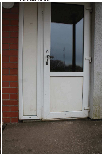
Kāpņu telpas ārdurvis
