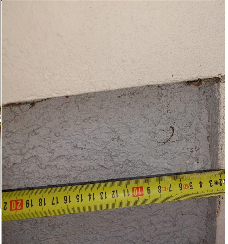
21. attēls (Plaisas dažāda pamatu līmeņa sienās 1÷2mm, skatīt foto Nr.14÷25, skatīt p.nr.5,6 telpas plānā)
