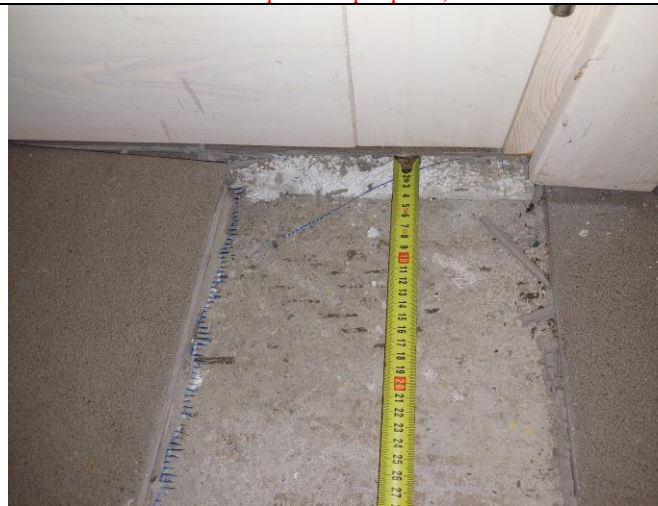
06. attēls (Grīdas uz grunts pieslēguma vietā pie esošās pamatu sienas izvietots putopolistirola plāksnes 40mm biežumā)
