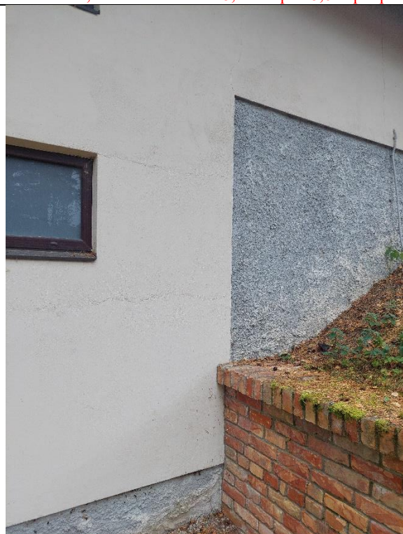
23. attēls (Plaisas dažāda pamatu līmeņa sienās 1÷2mm, skatīt foto Nr.14÷25, skatīt p.nr.5,6 telpas plānā)
