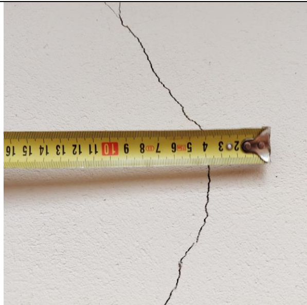
19. attēls (Plaisas dažāda pamatu līmeņa sienās 1÷2mm, skatīt foto Nr.14÷25, skatīt p.nr.5,6 telpas plānā)
