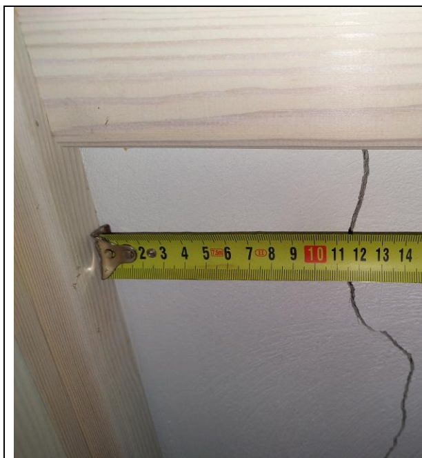
14. attēls (Plaisas dažāda pamatu līmeņa sienās 1÷2mm, skatīt foto Nr.14÷25, skatīt p.nr.5,6 telpas plānā)
