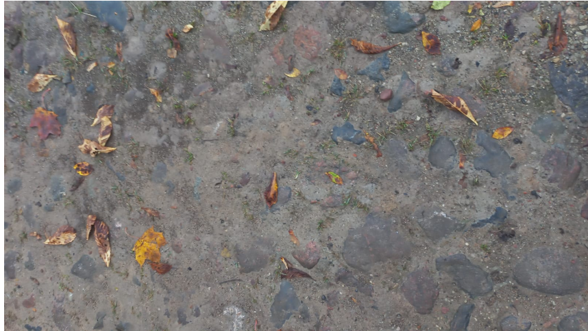
1.att. Skats uz teritorijā esošo vēsturiskā akmens bruģa segumu
